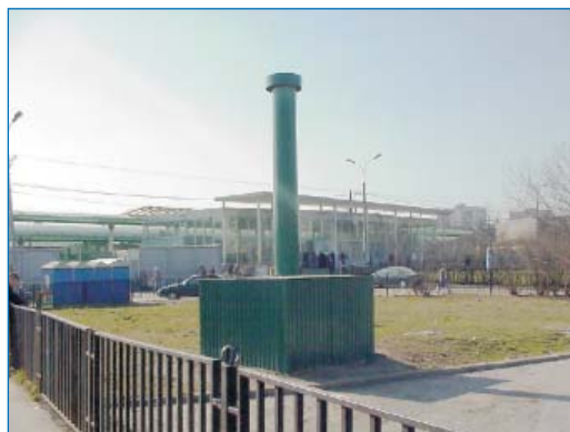
Метро «Выхино». Фильтр на Восточном канале
