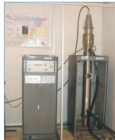
Установка на КНС «Нагатино 2»
