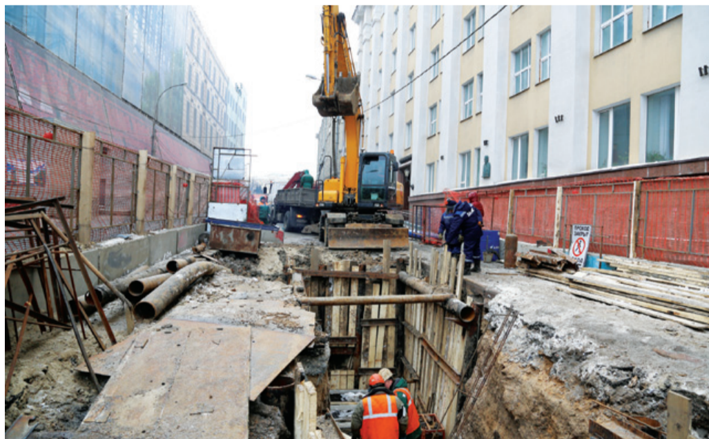
Реконструкция водопровода в Китайгородском проезде.
