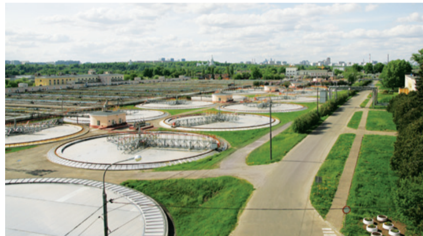
Реконструированные Курьяновские очистные сооружения
