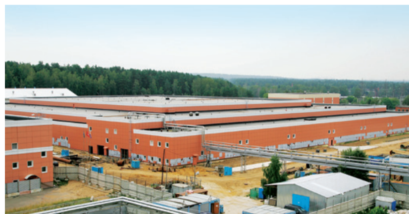
Строящийся новый блок Рублевской станции водоподготовки
