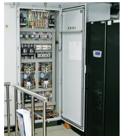
Оборудование нового ЦОД
