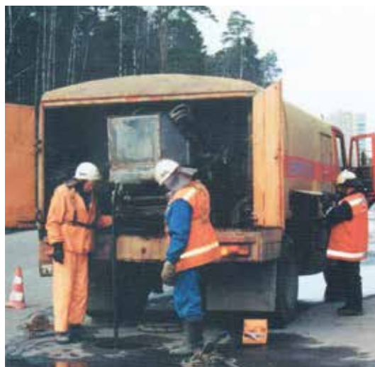
Работы на канализационной сети
