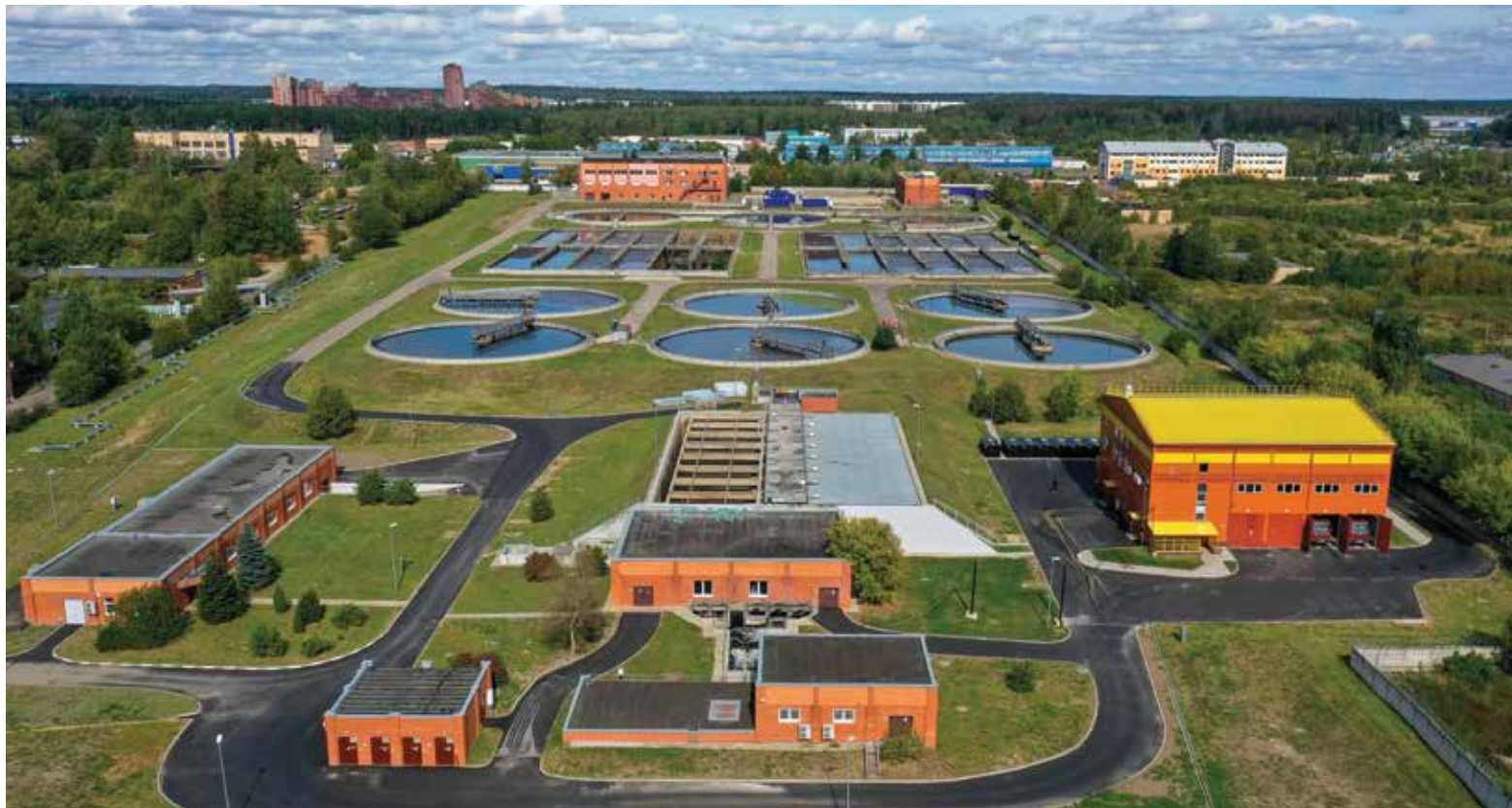
Очистные сооружения Зеленограда после модернизации
