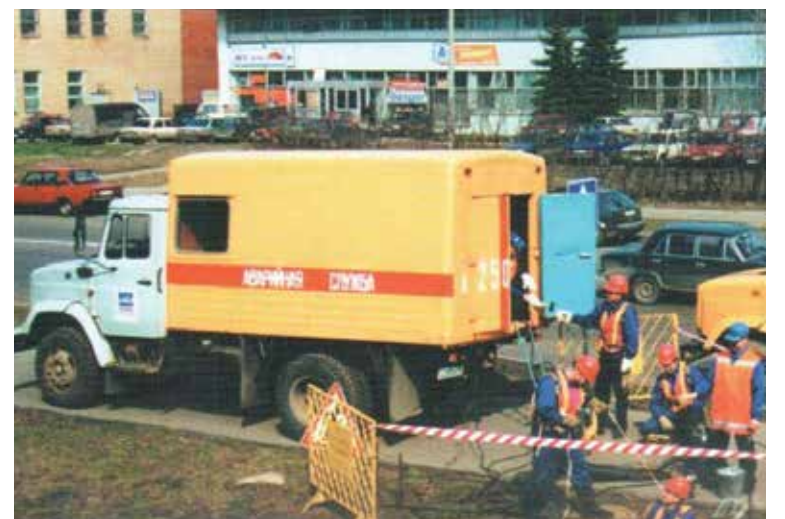
Работы на водопроводной сети
