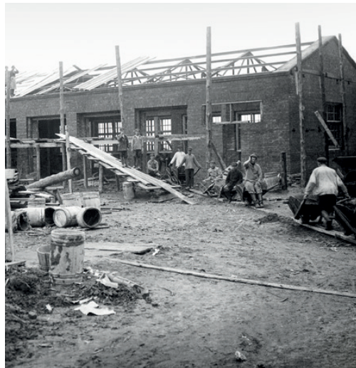
Строительство гаража станции.
