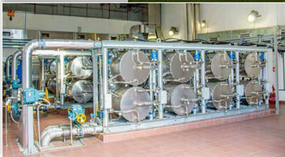
ЗАПАДНАЯ СТАНЦИЯ ВОДОПОДГОТОВКИ БЛОК ОЗОНОСОРБЦИИ
