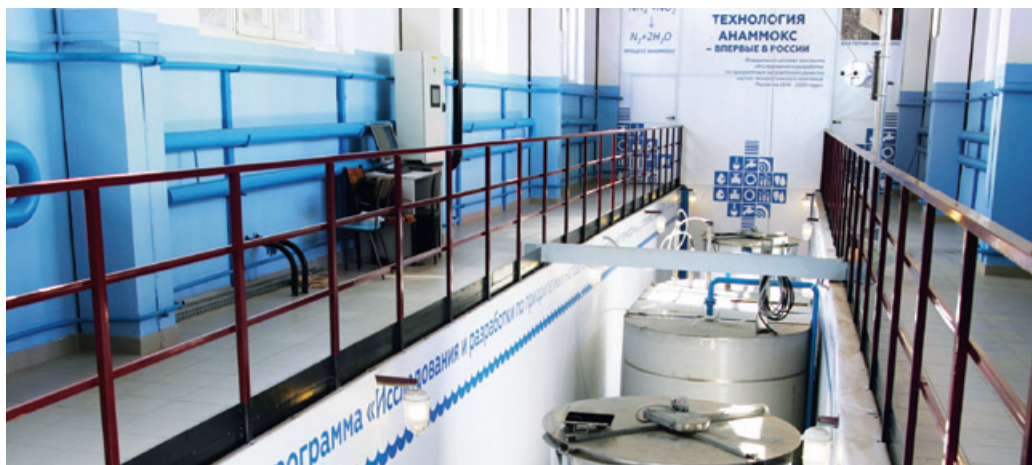
Первая в России полупромышленная установка, работающая по технологии «Анаммокс» на Люберецких очистных сооружениях
