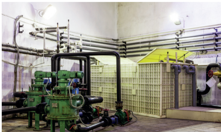
На фото: тепловые насосы в КНС «Северное Бутово»
