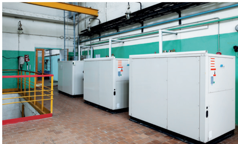
На фото: тепловые насосы в КНС «Северное Бутово»
