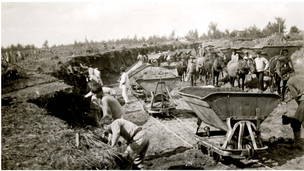
Рис. 2. Строительство полей орошения
