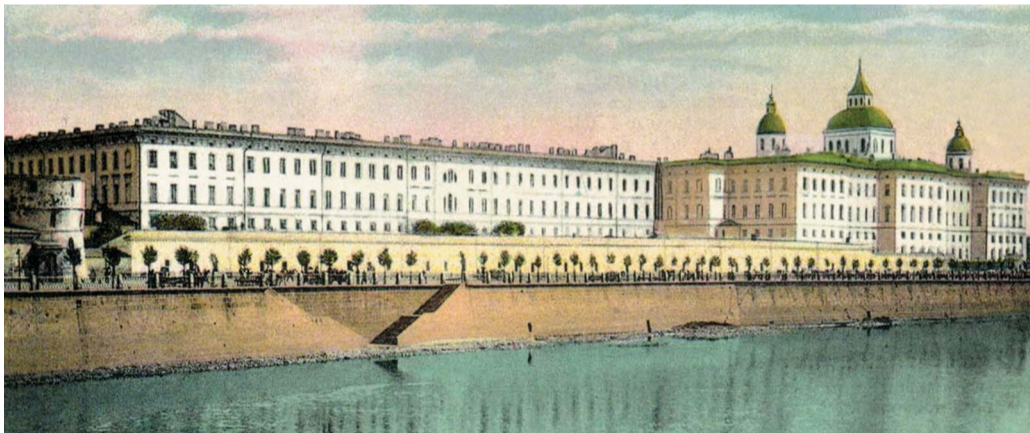
Воспитательный дом, одно из первых зданий, подключенных к водопроводу в Москве
